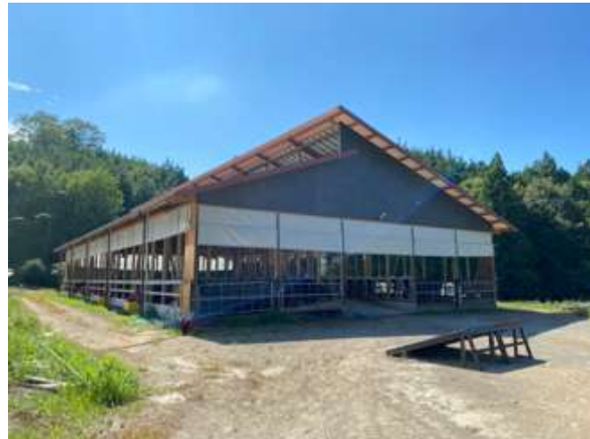
<基金の支援によって建設された牛舎>
