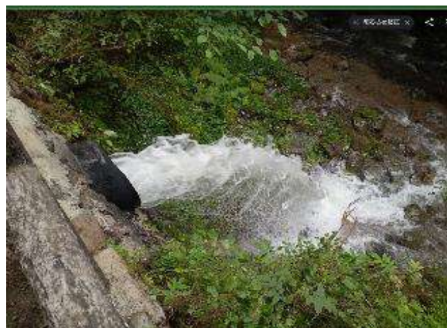
<水力発電用放水部分>
