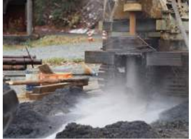
<井戸ボーリング工事の様子>
